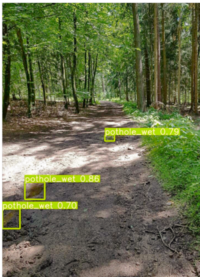
Die Erkennung von Schlaglöchern mittels KI hilft, den Zustand des Waldstrassennetzes und seine Funktionalität zu überwachen.
