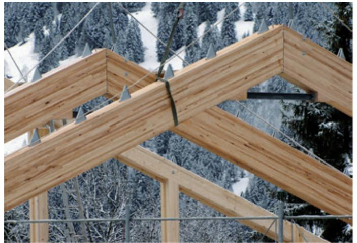
*Die besonderen Materialeigenschaften des Buchenholzes ermöglichen eine schlanke Tragkonstruktion.*
