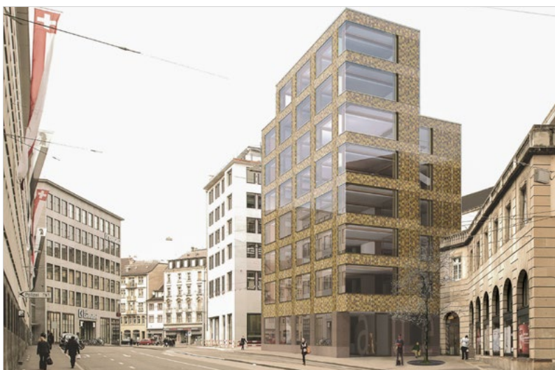
Der achtgeschossige Hybridbau mit fassadenintegrierter Photovoltaikanlage für das Amt für Umwelt und Energie (AUE) wird zeitgemässe Büroarbeitsplätze anbieten.
