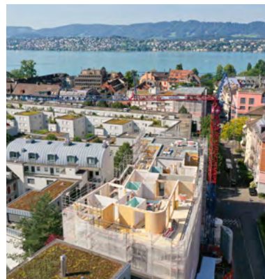
Neuer Wohnraum an bester Lage dank Aufstockung mit Holz: Im Zürcher Seefeld entstanden gleich vier neue Wohnungen auf einem Mehrfamilienhaus aus den Dreissigerjahren.
